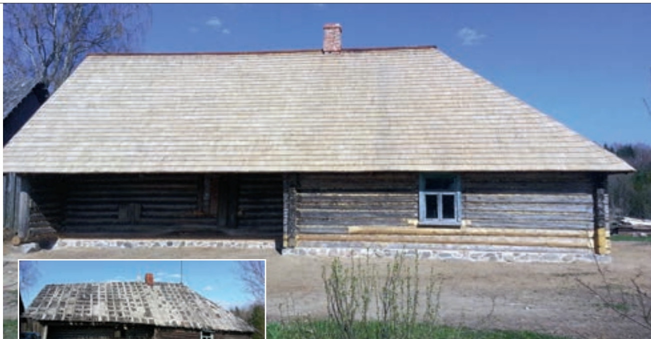
◀▲ Enne ja pärast. Olulisim on, milline on vundamendi, seinte ja katusekonstruktsiooni seis. Need kolm aspekti on võtmetähtsusega.
