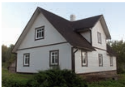
▲ Enne ja pärast. Kui on korralik palksein ja plaan vooder peale panna, siis pole mõtet seina väga palju soojustada.
