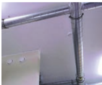
▲ Ülemisel poolisel fotol on tihendamata läbiviik katuse aurutõkkest. Termopilt alarõhu olukorras osutab, et suitsuanduri taga võib olla õhuleke. Alumisel pildil on termopildiga samal ajal tehtud tavafoto samast suitsuandurist.
