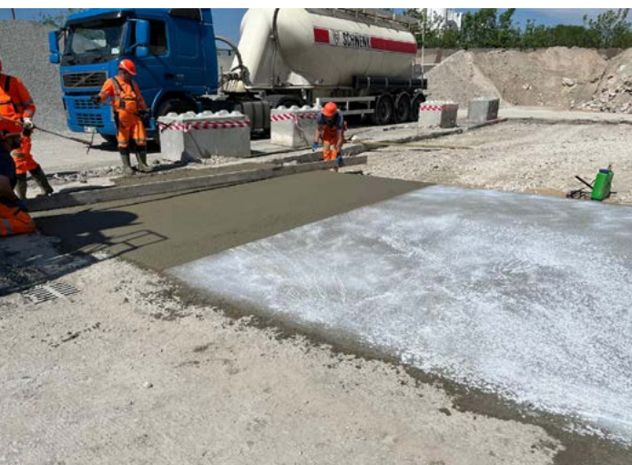
PILT 8: Järelhooldusaine (valget värvi) värskest valatud betoonplaadil. Vasakul olev osa tasandatakse ja kaetakse seejärel viivitamatult hooldusainega.
