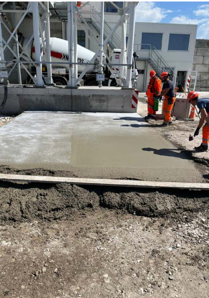
PILT 7: Värskest valatud ja tasandatud betoonplaadi katmine järelhooldusainega.
