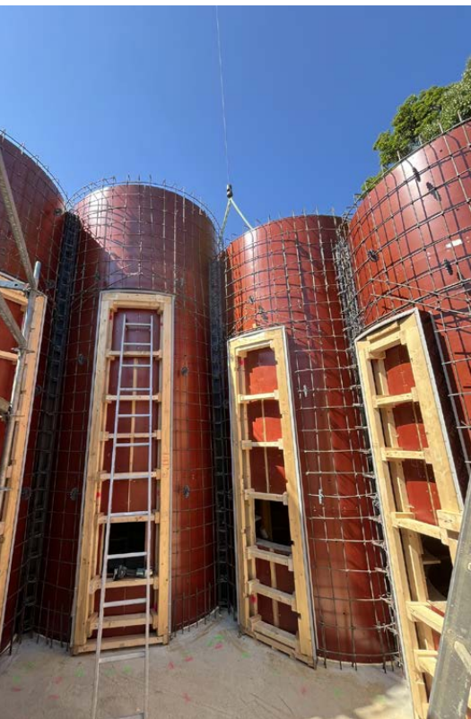
Raketiste monteerimine: sisemine vineer on paigas, samuti ühekordne armatuur ja ukseavad. Järgneb välimise raketise paigaldamine.
