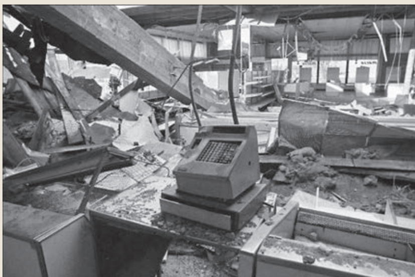
Marja poes viis ehitusviga katusevaringuni, kohe sai surma viis ja vigastada 13 inimest (neist üks suri veel haiglas). FOTO: PEETER LANGOVITS / RAHVUSARHIIV
