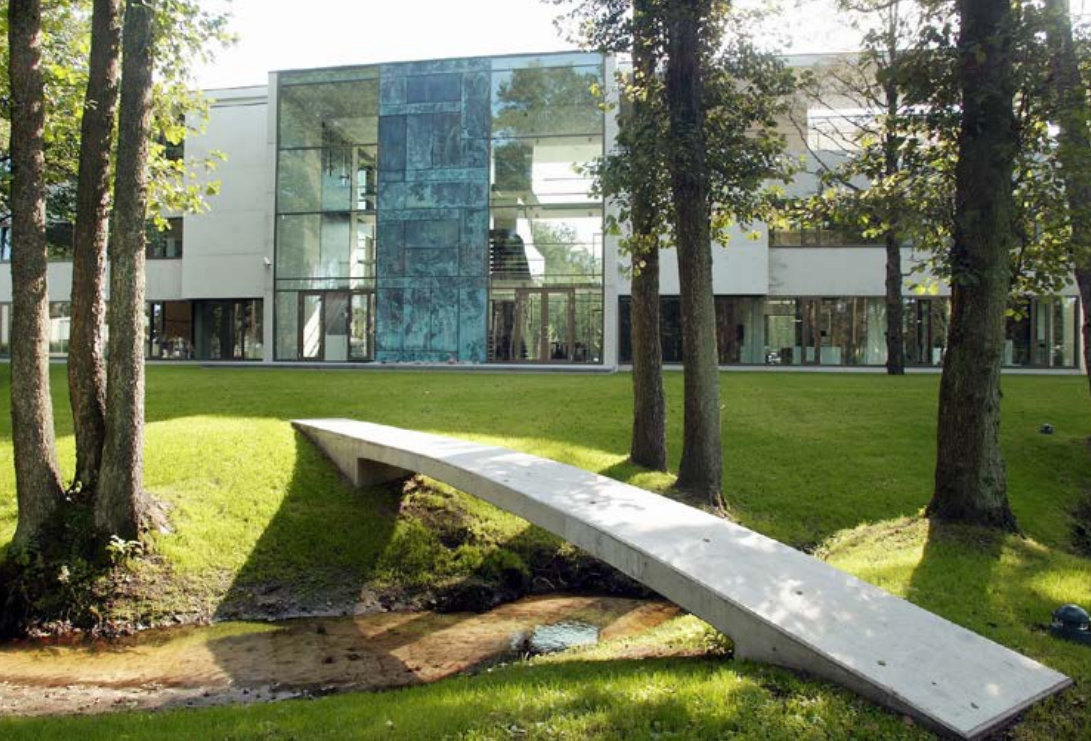
TTP büroohoone – aasta betoon-ehitis 2005. Arhitekt: Meelis Press
