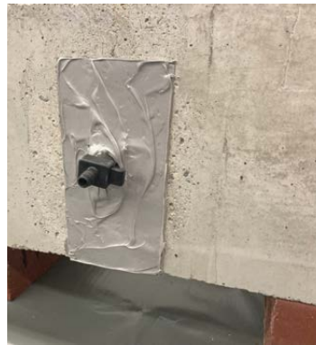
Peentehnoloogia: betoonipragude tammistus ja pragude täitmine läbi puurpakkerite kõrge survega ...
