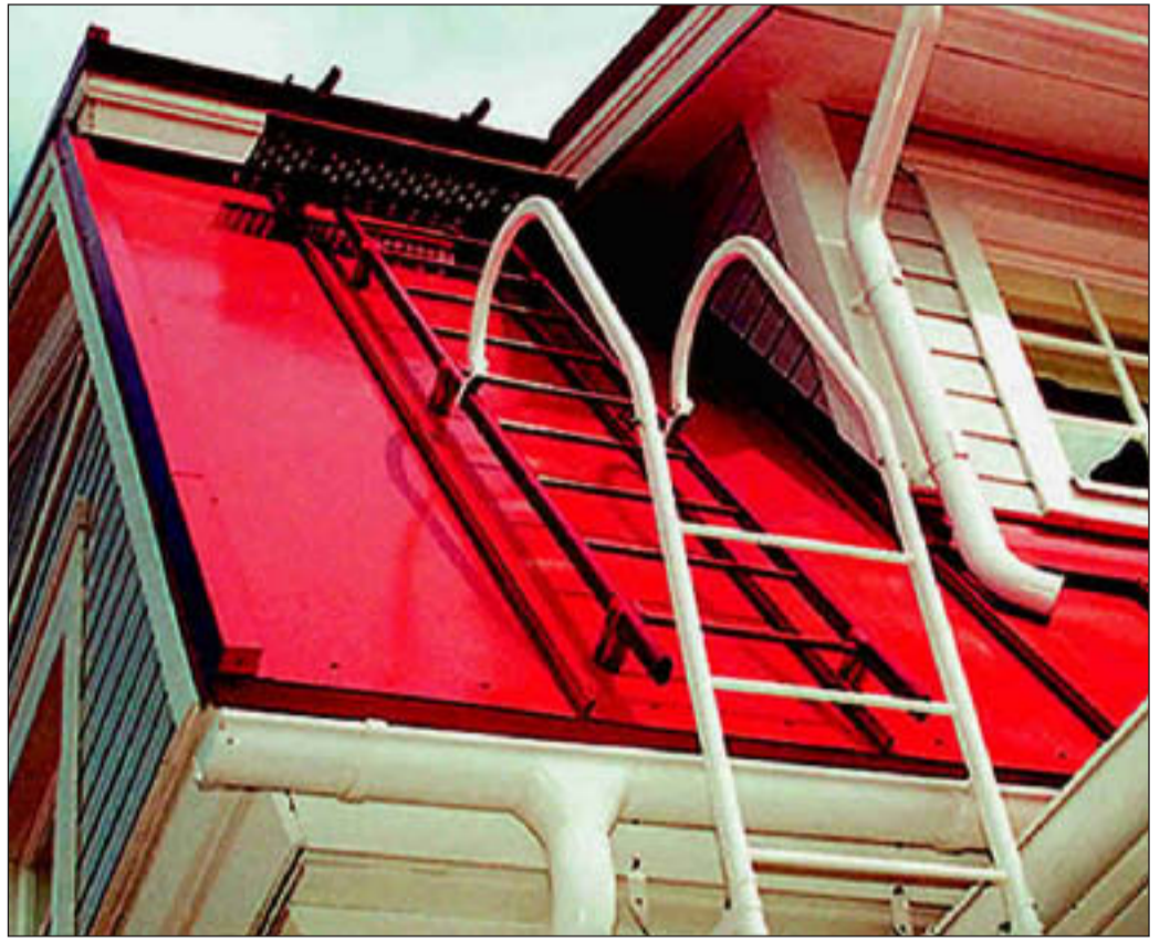
Korralik redel kuulub katuse juurde, ka vihmaveesüsteem tuleks läbi mõelda enne ehituse algust. Foto: Ruukki Products AS
