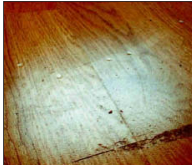
Niisuguseid kontsajälgi ja plekke ei tohiks uues põrandas vastuvõtmise hetkel olla.
