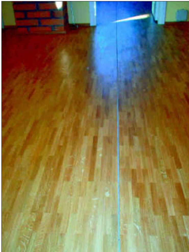
Vale paigalduse ja väikese õhuniiskuse tõttu on pinge uude põrandasse suure praod tõmmanud.
