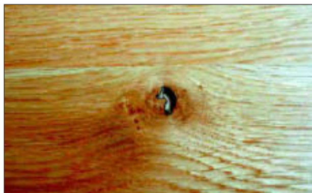
Väikeste oksakohtade auke põrandas saab parandada kitiga.
