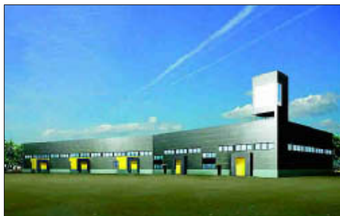
Peterburi tee ja Tänassilma tehnapargis valmivad sel sügisel uued laokompleksid, rendihinnad esimeses 80-90 kr/m 2 ja teises 80 kr/m 2 . Pildil Peterburi tee kompleks. Foto: Uus Maa
