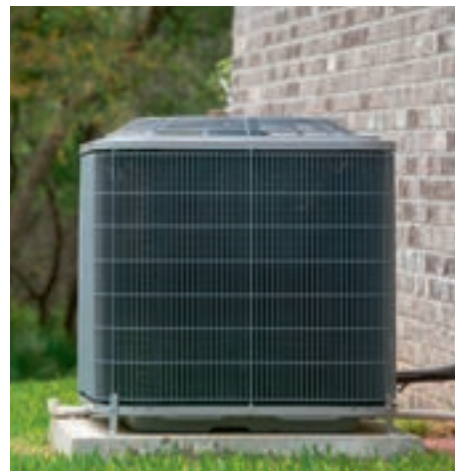
↑ Õhk-vesi soojuspumpa on lihtne kombineerida majas olemasoleva küttesüsteemiga.
