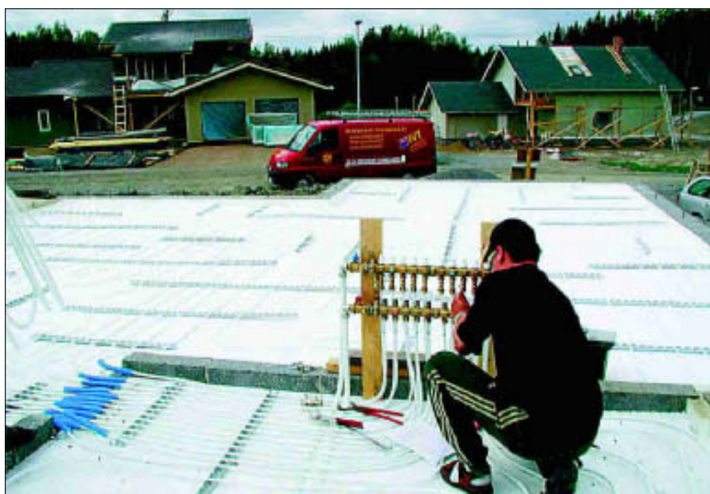
Põrandasse vesikütte paigaldamine sobib eelkõige siis, kui on tegemist uue ehitisega või kapitaalset remondiga.
