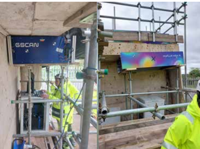
Järelingestatud raudbetoonist silla elemendi läbivalgustamine Suurbritannia uurimisprojekti "Structures Moonshot" raames. September 2023.
