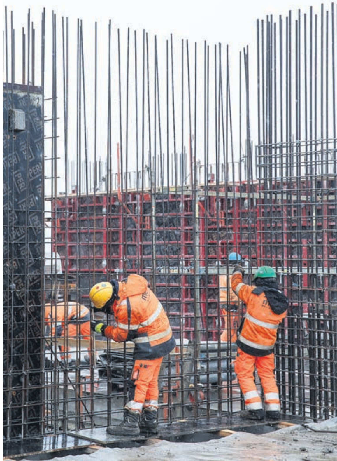
▲ Merko ehitajad paigaldavad Maakri maja kõrghoone metallkarkassi betooni valamiseks. FOTO: RAUL MEE
