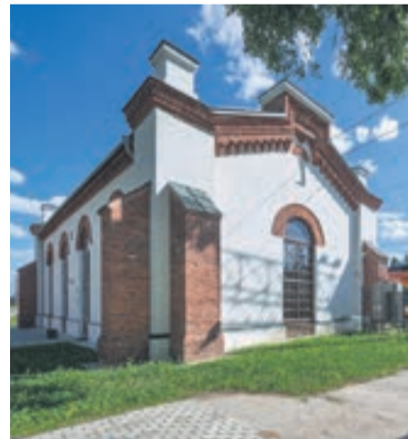
▲ Aegviidu vana depoohoone rekonstrueerimistööd, kus ühildati oskuslikult nii vana kui ka uus.
